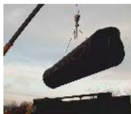
2. OPUSZCZANIE ZBIORNIKA DO WYKOPU
