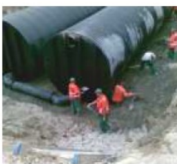
3. ZAGĘSZCZANIE STREFY PACHWINOWEJ ZBIORNIKA
